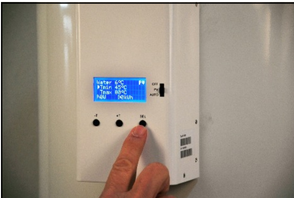
19. Uporabite "SEL" gumb z izbor Tmin ali Tmax da nastavite željeno temperaturo z uporabo gumbov + in -.
