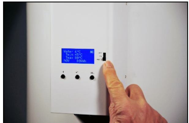
20. Izberite željen režim ogrevanja s premikom stikala. Pred prvim zagonom mora biti stikalo na poziciji OFF.
